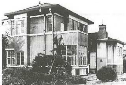
①所長室（平野医院住宅棟） 戦後、南方貨物線工事にともない姿を消した。
